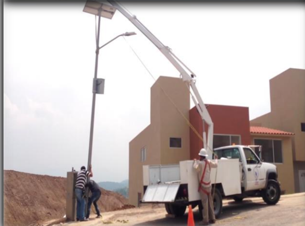
Montagem de iluminação pública fotovoltaica em Cambambe
