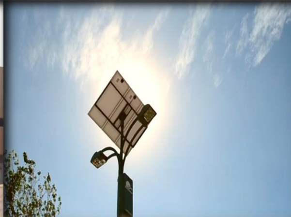
Iluminação pública fotovoltaica no Cunene, Angola
