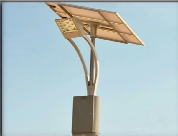
Iluminação pública fotovoltaica em Malanje, Angola
