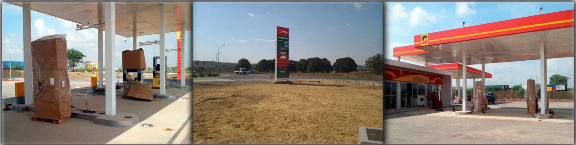
Concepção, fornecimento e montagem de uma estação de bombagem para SONANGOL e outra para PUMANGOL em Luanda e Benguela, Angola.
