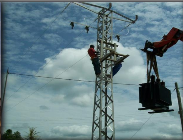
Montagem de transformador de ar em Dondo, Kwanza Norte de Angola
