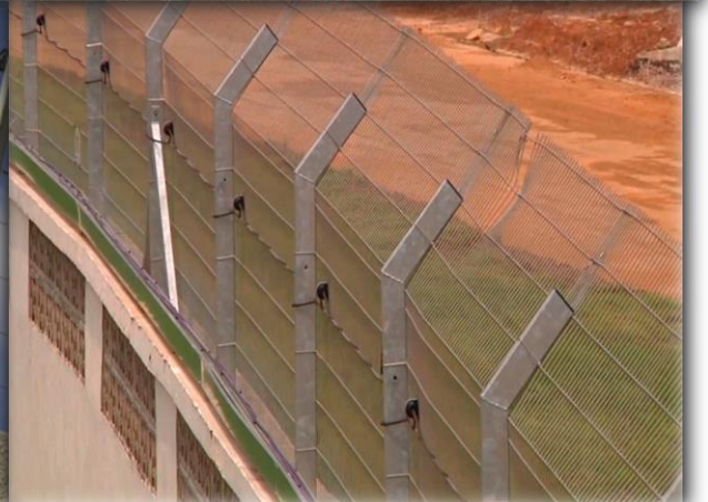
Vedação de Protecção do Aeroporto do Huambo, Angola
