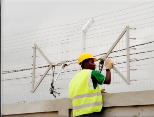
Montagem de vedações de segurança
