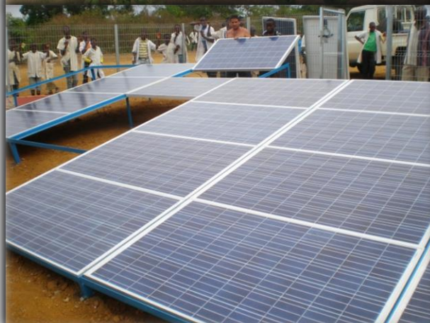
Painéis fotovoltaicos para uma estação de purificação de água em Fazil, Angola
