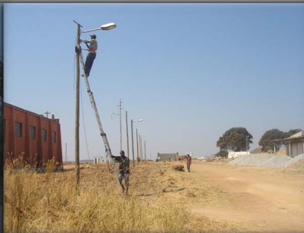
Instalação de iluminação pública em Lubango, Angola
