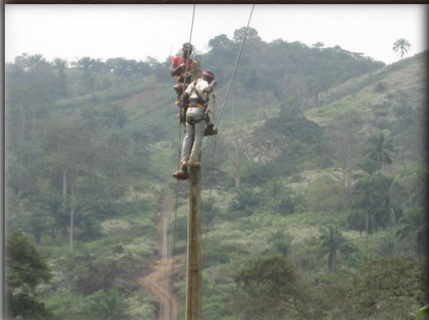
Manutenção da linha de distribuição em Lumeje , Angola
