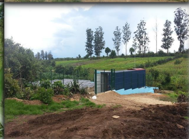
Unidade de purificação de água com fornecimento de energia solar no Parque Nacional da Cameia, Angola
