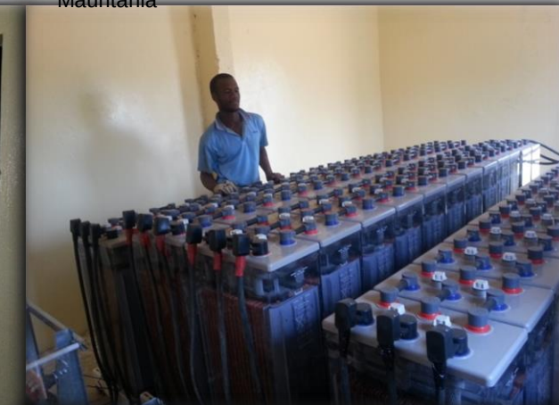
Baterias para centrais eléctricas híbridas em Ain Taya, Mauritânia
