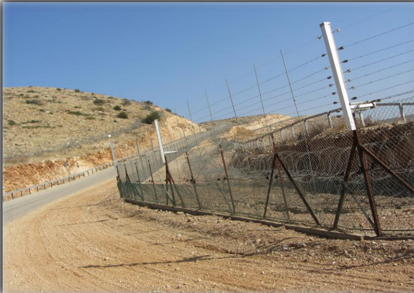
Vedação de segurança num posto fronteiriço
