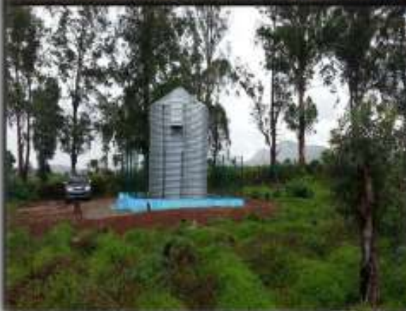
Depósito de agua en el parque Nacional de Kissama
