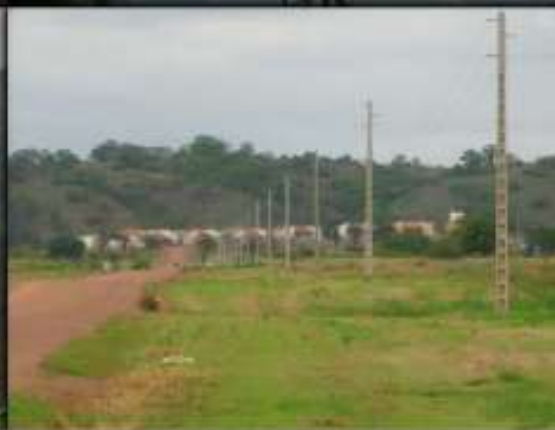
Línea de distribución en Luena, provincia de Moxico
