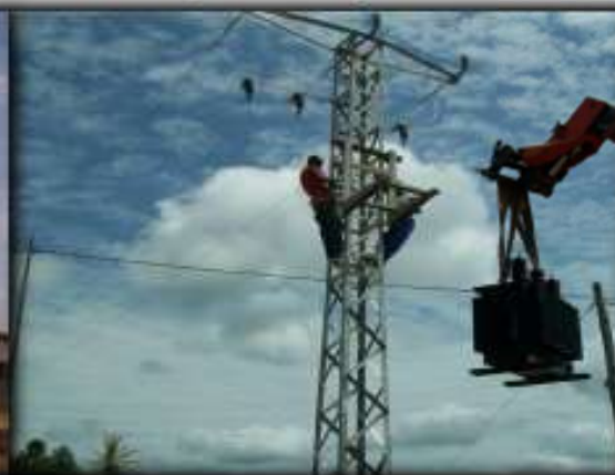
Instalación de transformador aéreo en línea de Kinshasa, República del Congo
