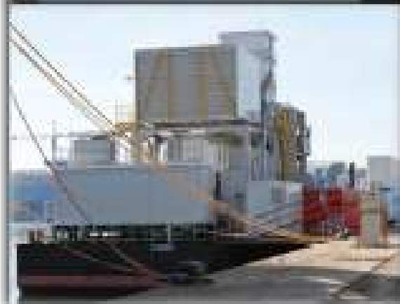
Central térmica de 42 MVA móvil, en barcaza
