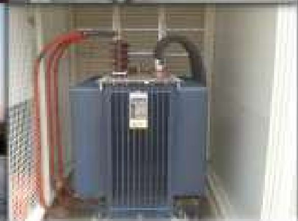
Instalación de transformador en Cambamba, Kuanza N.
