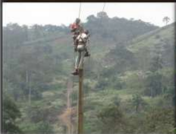
Trabajos de mantenimiento en línea de Lumeje, Moxico
