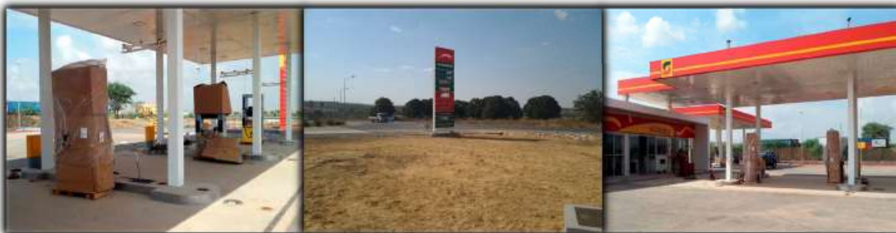
Diseño y montaje de una gasolinera de SONANGOL y línea de distribución de PUMANGOL, Luanda y Benguela
